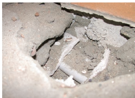
Afb. 7 Gebrek aan cohesie van het onderste deel van de dekvloer.
