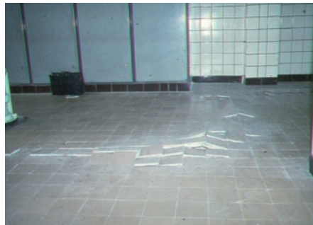
Afb. 1 Opwelling van een betegeling op een gestabiliseerd zandbed.
