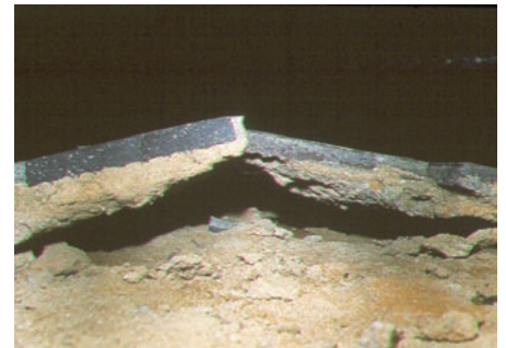
Afb. 1 Opwelling van een betegeling op een gestabiliseerd zandbed.
