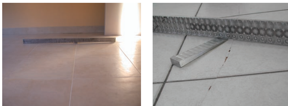
Afb. 17 Opwelling van en scheurvorming in het geheel dekvloer-betegeling.
