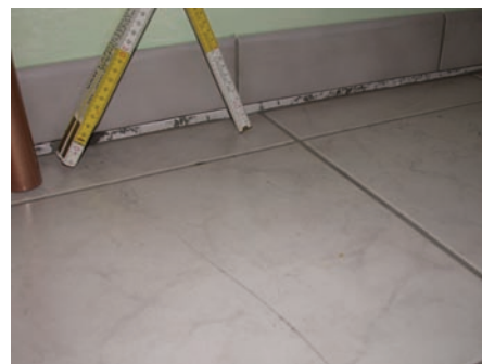
Afb. 19 Verzakking in de buurt van de plint.
