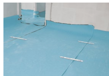
(3) \pm 15 cm tegen de muren naar boven komen voor de realisatie van de chape
