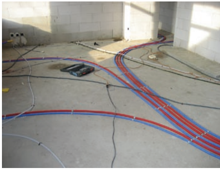
Afb. 2 Leidingen die aangebracht werden op de draagvloer.
