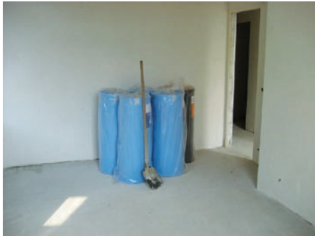
Afb. 5 Reiniging van de werf vóór plaatsing van de elastische tussenlaag.
