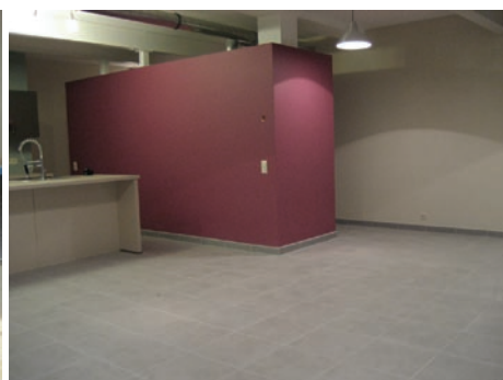
Afb. 13 Afwerking van de voegen aan de plinten en tussen de tegels met siliconen.
