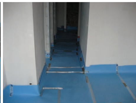
Afb. 10 Plintopstand van de elastische tussenlaag : aandacht voor uitspringende hoeken.
