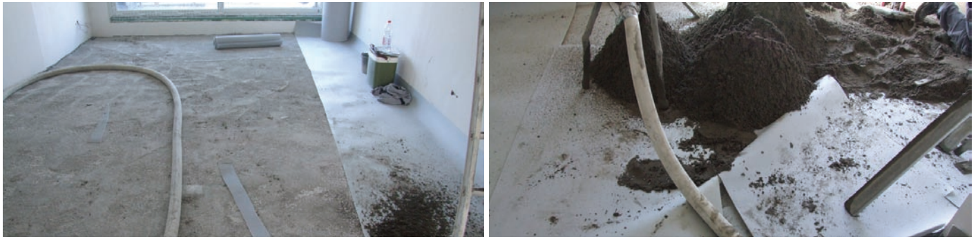
Afb. 14 De contactgeluidsisolatie kan onherroepelijk aangetast worden door het ontstaan van akoestische bruggen tengevolge van : een slechte voorbereiding van de uitvullaag (voorwerpen die de tussenlaag kunnen perforeren), het belopen, gereedschap dat onnodig op de tussenlaag achterblijft, onvoldoende overlapping van de naden in de onderlaag, ...
