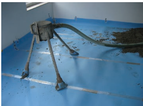
Afb. 9 Bescherming van de elastische tussenlaag tegen de voeten van de driepikkel.
