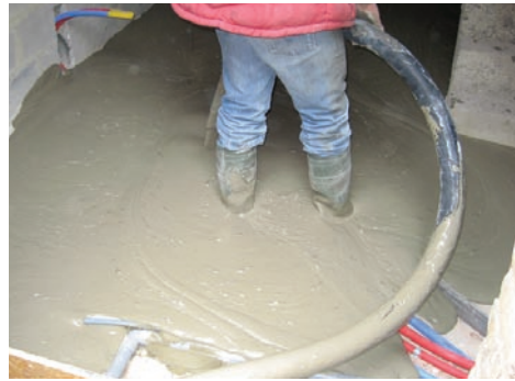
Afb. 3 Uitvulling van het type cellenbeton.
